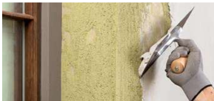
Aplicación de Planitop 210
